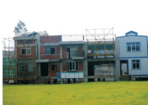
建筑施工综合实训场
